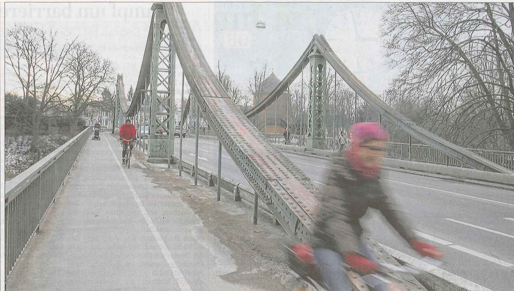
Noch ist die Fahrt in beide Richtungen frei, doch ab Montag wird auf der Mühlentorbrücke ein Rohr repariert.
